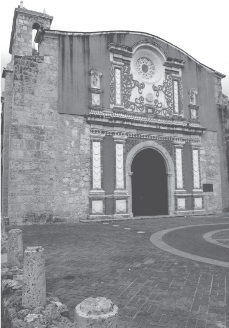
Convento de los Dominicos. Fuente: fotografía Odalís Rosado.
